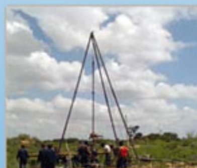
工厂预制式深井阳极施工
