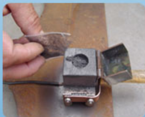
第五步：将点火粉撒在焊剂表面以及模沿上。
