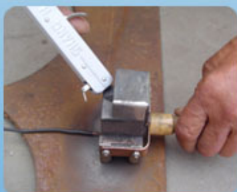
第六步：将模具盖盖好，一切准备就绪后用点火枪点燃焊剂（一般1-3次打火点燃）。
