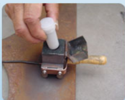
第四步：将焊剂倒入模具，用提供的专用木棒（或焊剂瓶）将焊剂压实。
