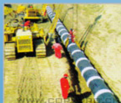
绝缘支撑架施工
